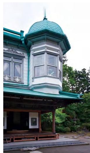
空中楼閣とも呼ばれた展望室。1階の2本の柱が重さを支えている
