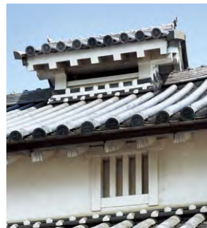
煙出しの役目を果たす越屋根。釜屋の上部にある
