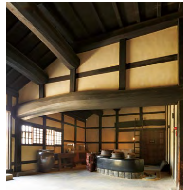
釜屋の梁は煙返し梁と呼ばれ、深い垂れ壁と梁には煙が流れ出ることを防ぐ機能があった
