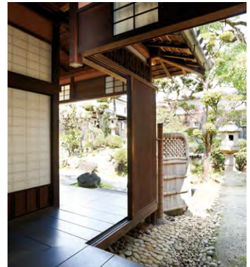
屋根裏の部材がこの原理で軒を支え、縁側角の柱を省略できたと考えられている
