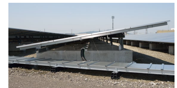
暴風時の風圧荷重や発電効率を配慮して傾斜角度は10度に設定された
