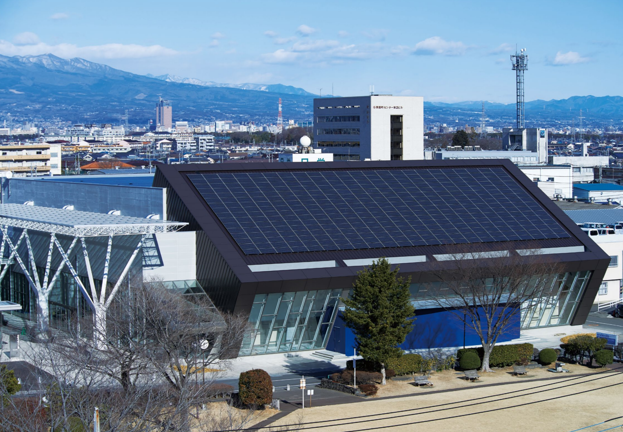
太陽光発電システムの効率を高めるため、30度傾斜した屋根にパネルが設置されている
