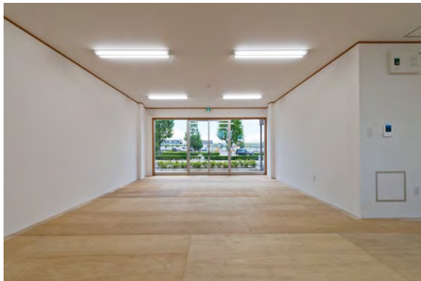
左右の壁はテナント工事で将来的には一部撤去することも想定して構造計算されている
