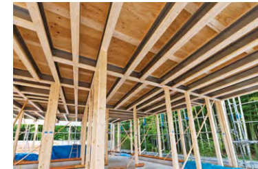
500mmピッチで<テクノビーム>が配置された2階床
