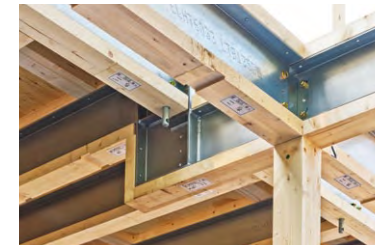
フラットバルコニーにスノコを置くために段差が設けられた<テクノビーム>
