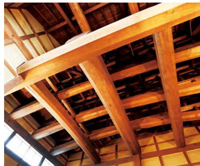
虫除けのために白太を削って八角形になった土間の梁。元はさらに太かったことになる。小屋組も見える
