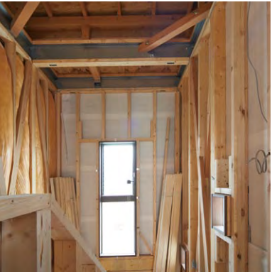
階段吹き抜け部のテクノビーム（工事中）
