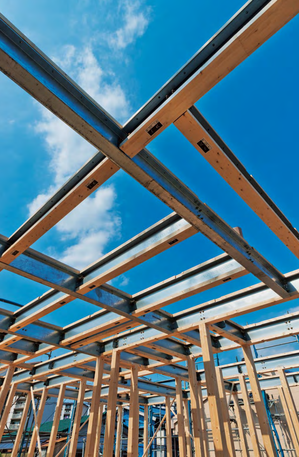
木と鉄の複合梁<テクノビーム>の上に、寄棟造の屋根が組まれている。(写真左は屋根施工前の2階部)
