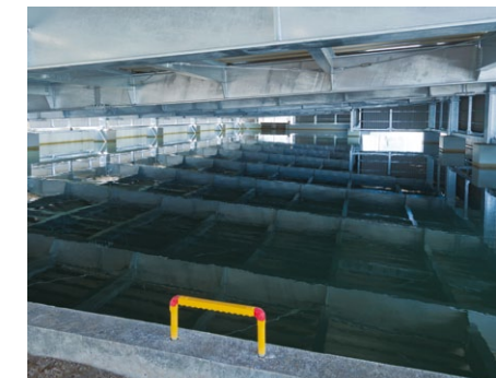
調整池の上を覆う太陽電池モジュールが藻や水草の発生を抑える
