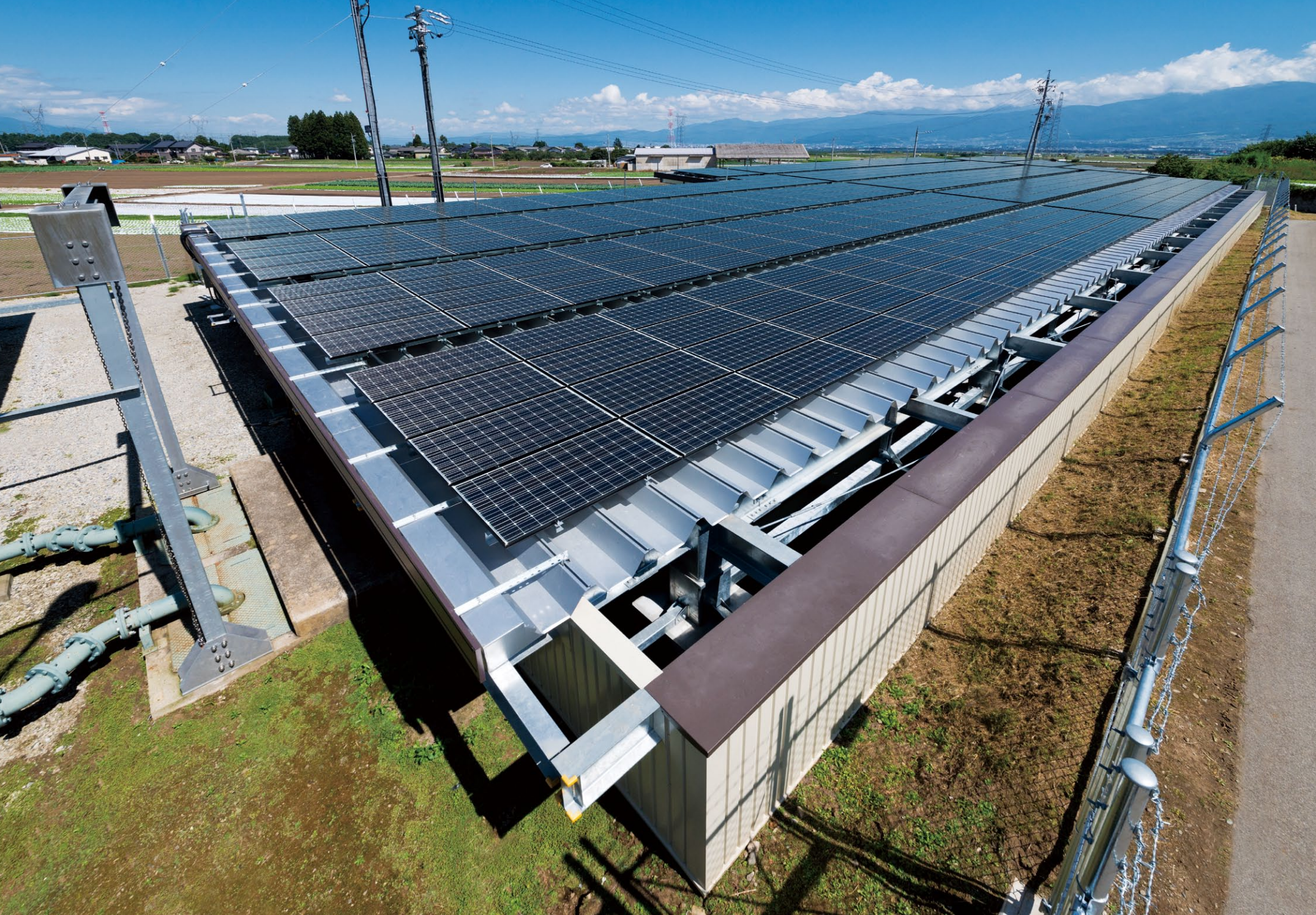
調整池を覆うように地上から高さ3mの屋根上に設置された太陽電池モジュールHIT240×640枚
