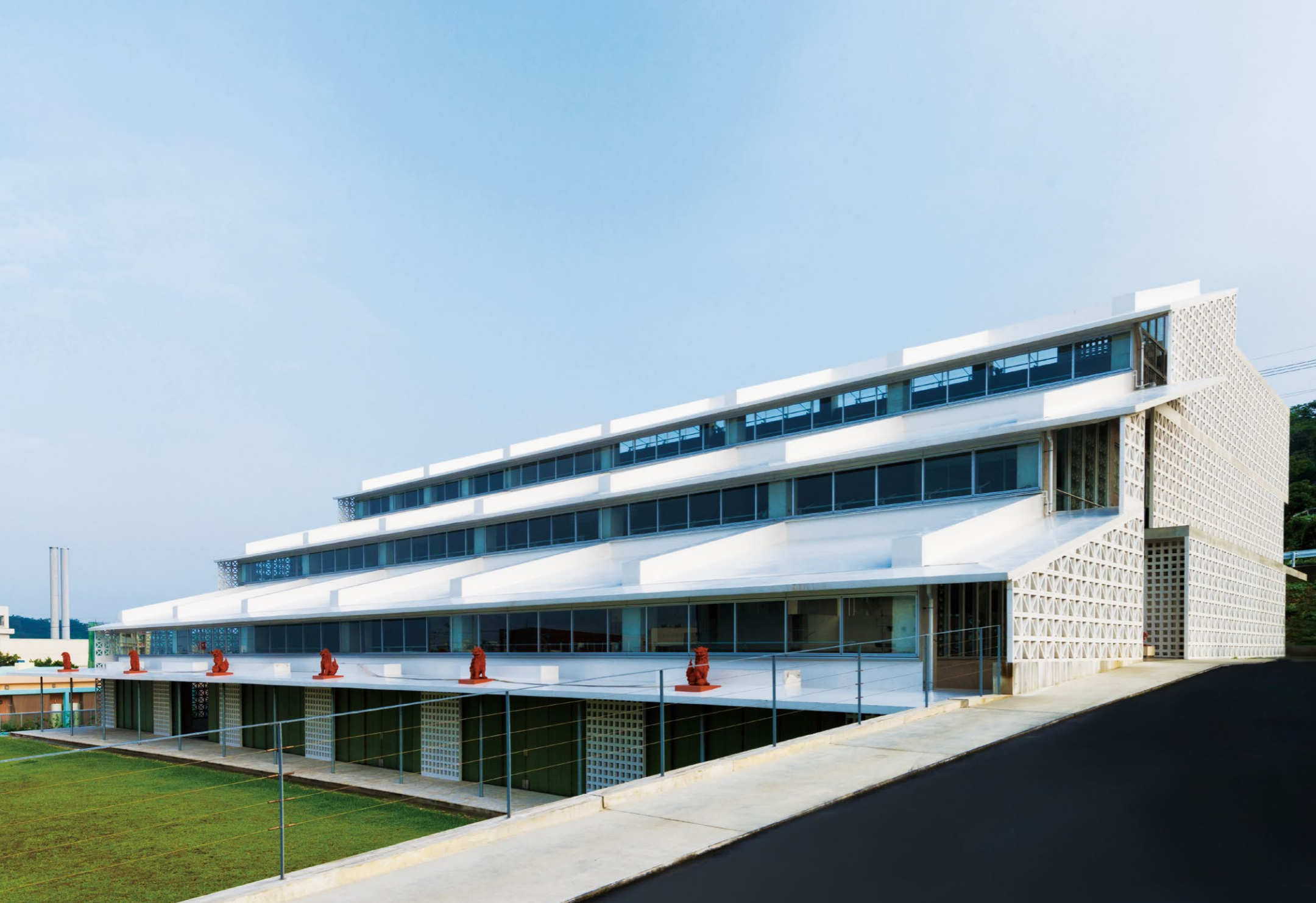
各層の大屋根下に設けられた開閉式の換気窓は存在感を消すために細いフレームが用いられている
