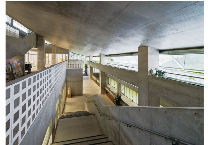
逆梁によって実現された平滑な天井面に外光が反射して地明かりを確保している
