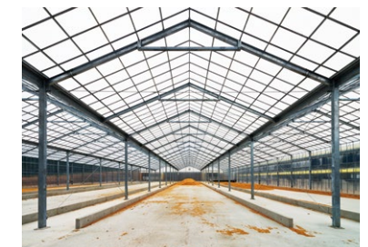
生産した堆肥を乾燥・保存する乾燥堆肥舎
