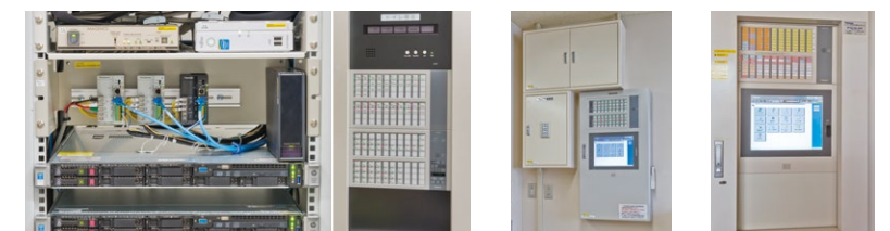
町役場のEMSサーバ(左)と照明・空調を制御するWeLBA(右)
