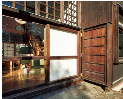
雨戸は戸袋に納め、戸袋ごと90度、回転させることができる。雨戸で開口部をふさがないための工夫。
