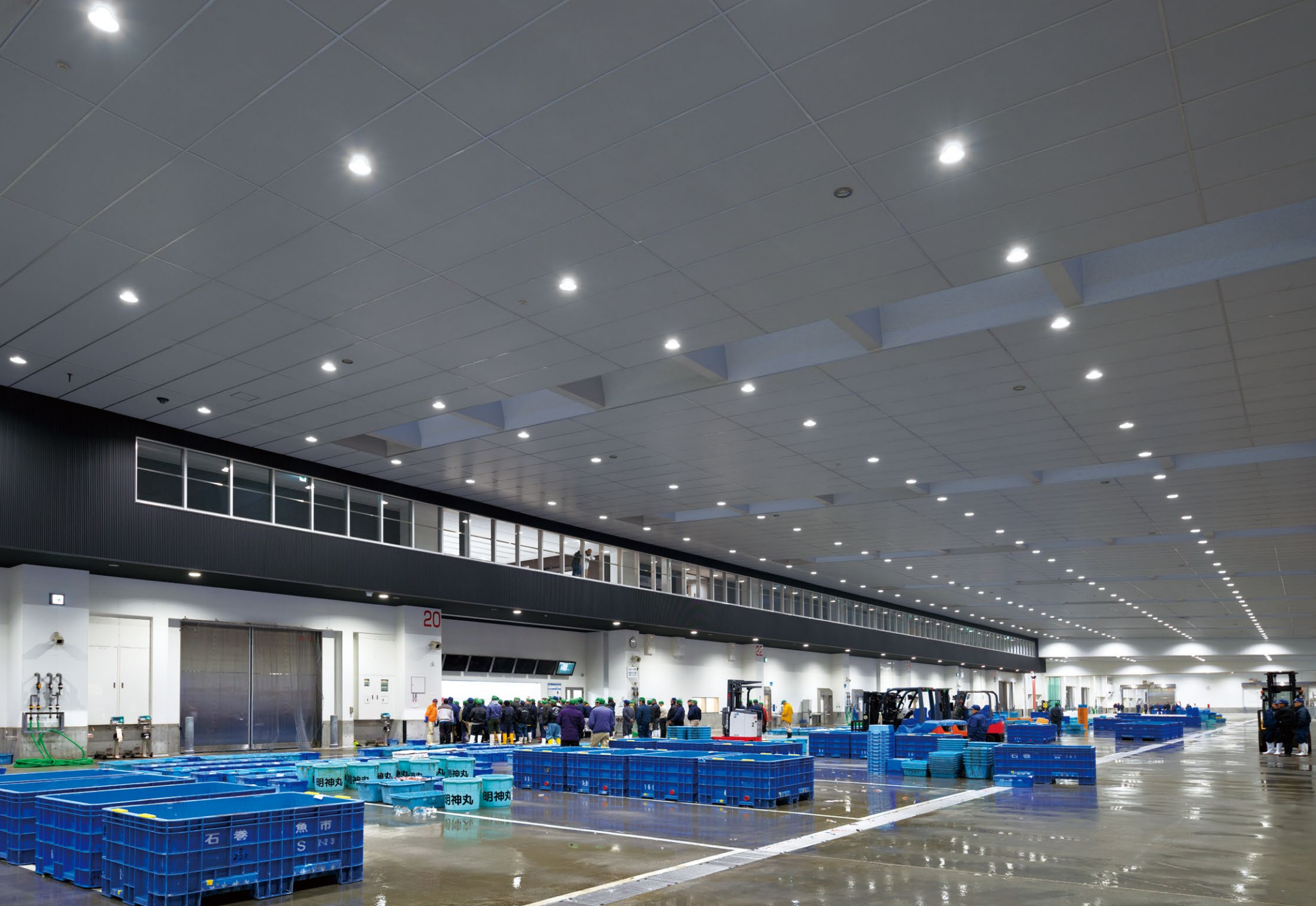
荷捌場の沖合・近海小型底曳きゾーンに設置された、Ra85、5000K、防湿型で重耐塩仕様、調光可能型の特注LEDダウンライト
