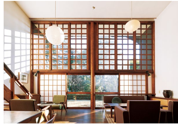
サロン南側の格子窓はレーモンド設計の東京女子大学礼拝堂からヒントを得たものという。下のガラス戸のレールは木製。当時は金属が入手しにくかった。
