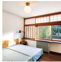
寝室の障子は壁に寄せることができ、窓が目一杯、広がるようになっている。
