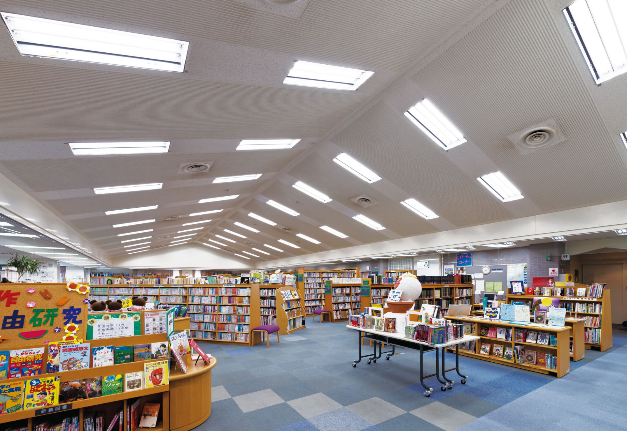
消費電力の少ないLED器具に一新された図書館の照明設備
