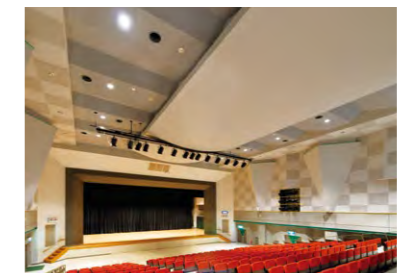
コミュニティセンターの多目的ホール照明もLED化
