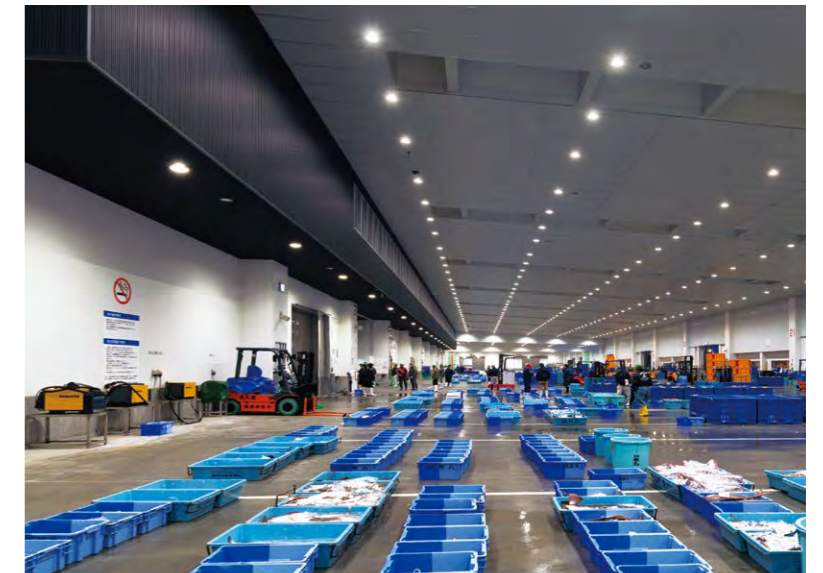
2階の見学者通路の下にもLEDダウンライトが設置されている
