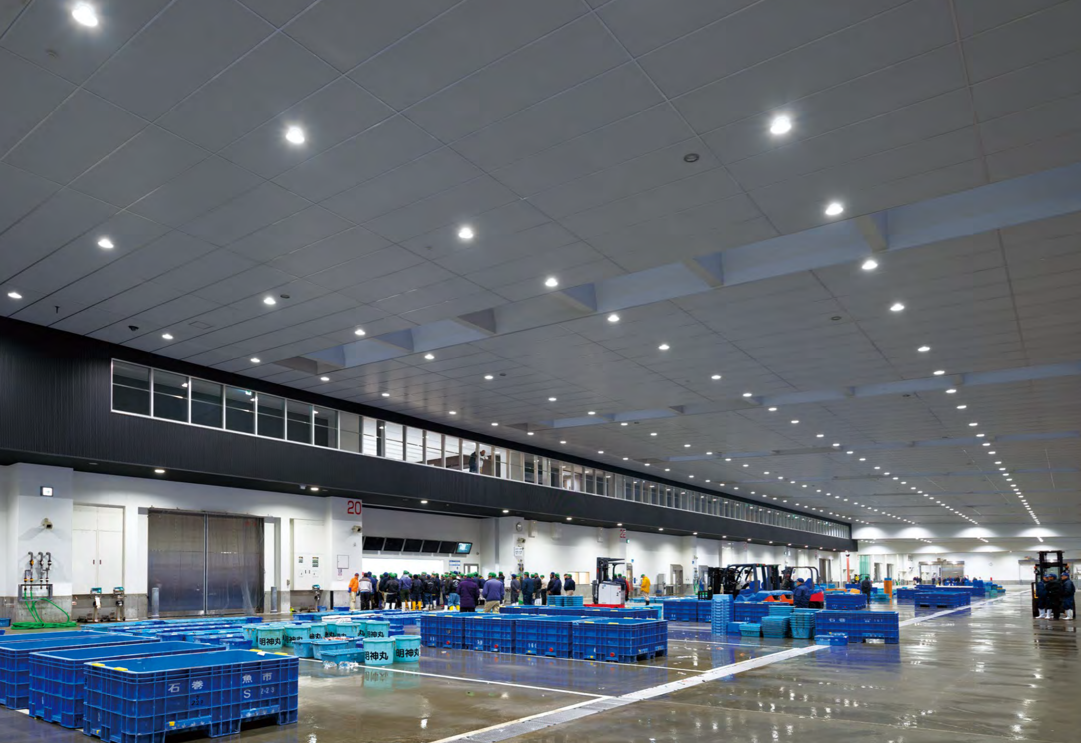
荷捌場の沖合・近海小型底曳きゾーンに設置された、Ra85、5000K、防湿型で重耐塩仕様、調光可能型の特注LEDダウンライト
