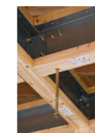
X線撮影機器の荷重に対応するためピッチを詰めてテクノビームを配置
