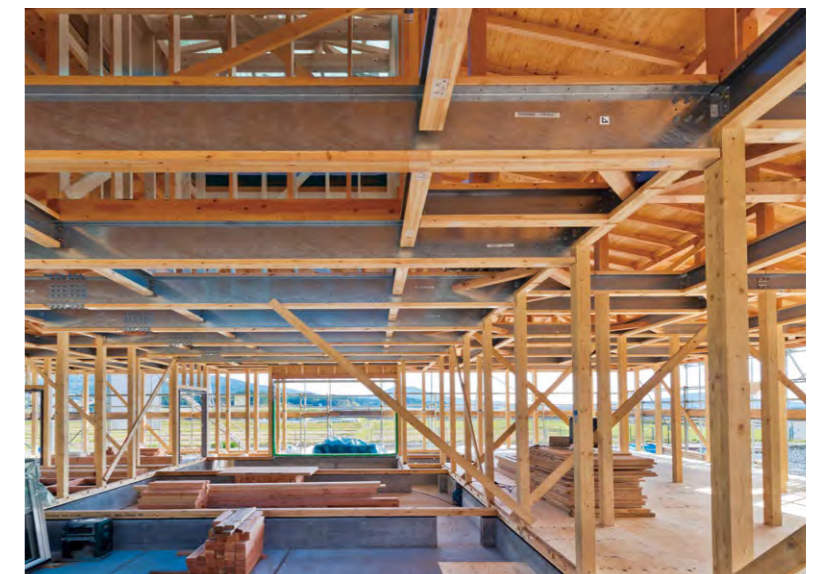
無柱の吹き抜けロビーでは耐荷重の大きなテクノビームが用いられている
