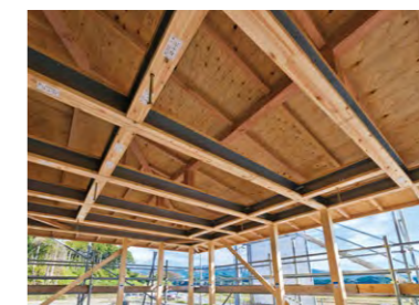
X線撮影機器の荷重に対応するためピッチを詰めてテクノビームを配置
