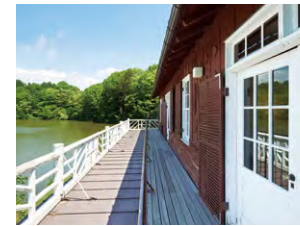
デッキの手摺りは白く塗った丸太を複雑に組み合わせてある。
