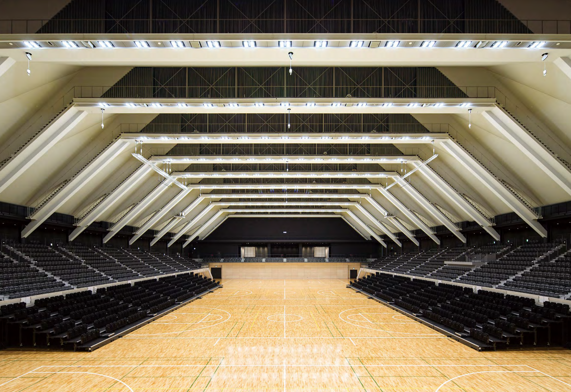
3600m 2 のメインアリーナではキャットウォーク下にLED高天井用照明器具を配置し、点滅回路を細分化することにより用途に応じた照度の調整が可能となっている
