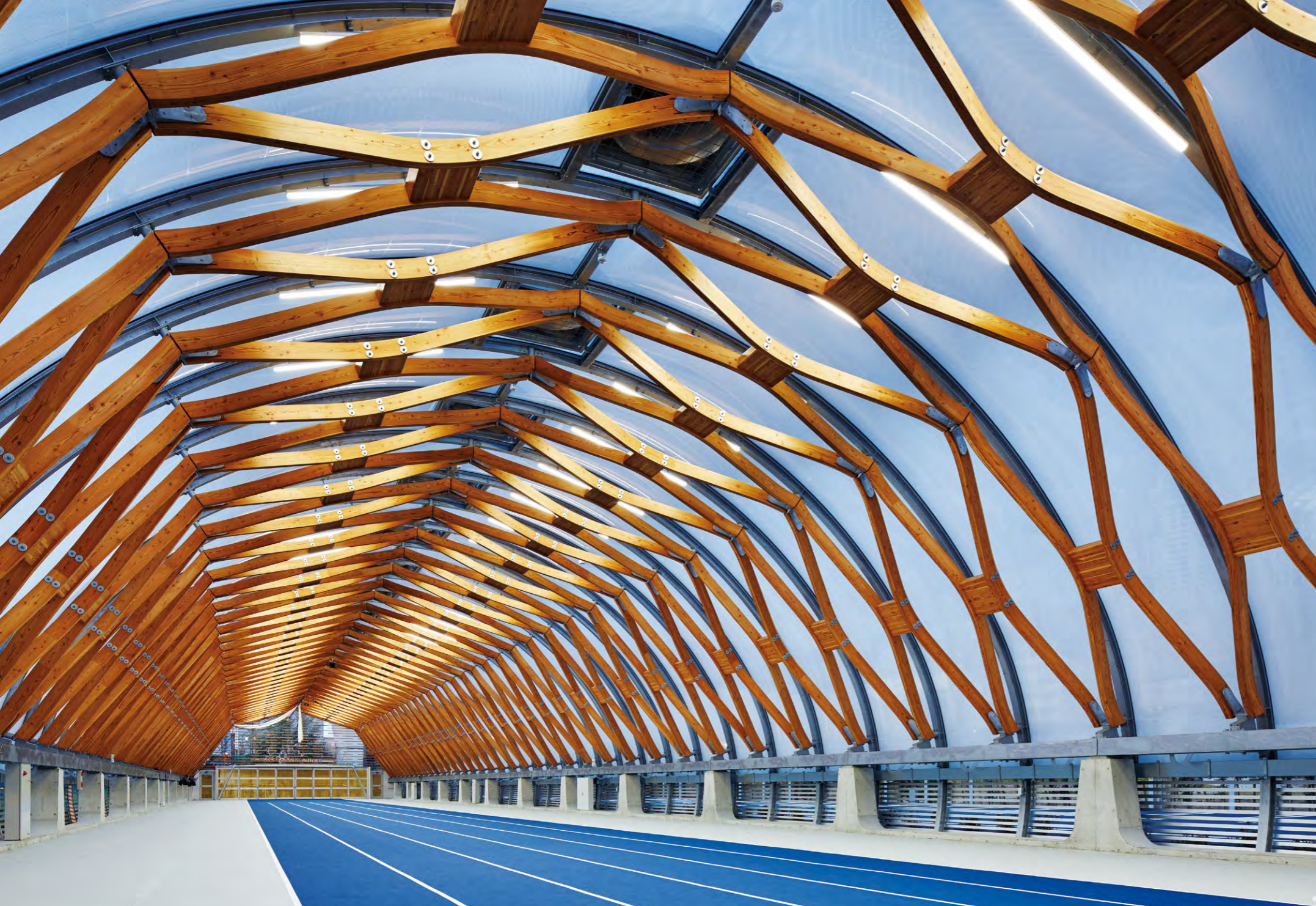
6レーンの60mランニングトラックは一体型LEDベースライトiDシリーズによって夜間練習環境としての平均照度500lxが確保されている
