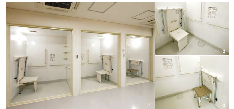
車いすのまま使えるシャワー設備 ①3枚スライドドア ②いすありタイプ ③いす無しタイプ
