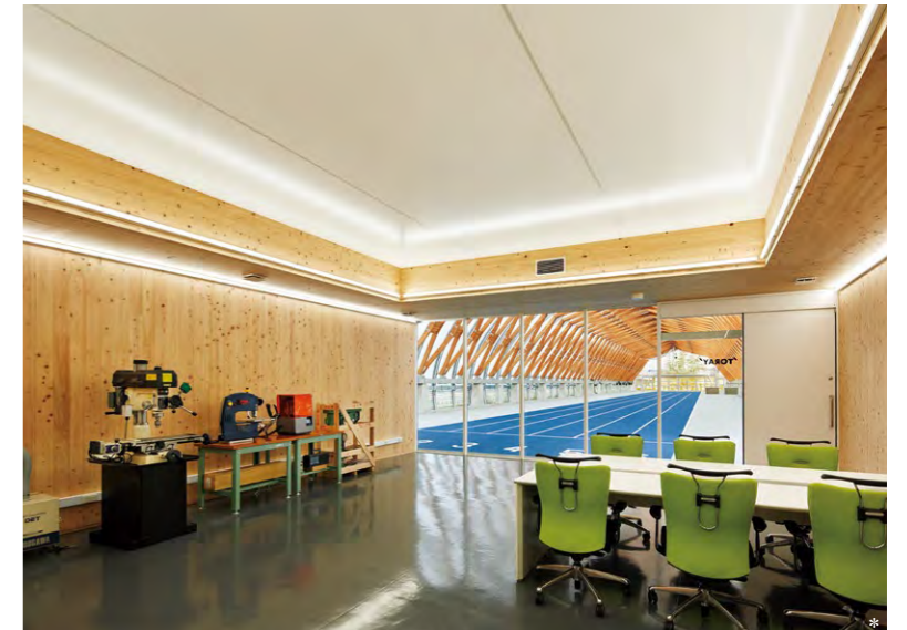
檜と杉によるCLT *2 を構造材として用いたオフィス。檜の美しい表情をライン照明が際立たせている
