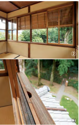
①3階の望楼は一間半四方で、全方向がガラス窓。東山・鴨川へ開ける眺望が素晴らしい。②視界を広げるために窓の位置には一切、壁を造っていない。雨戸は腰壁にある戸袋から引き上げる。③戸袋には横長の雨戸が収納されている。
