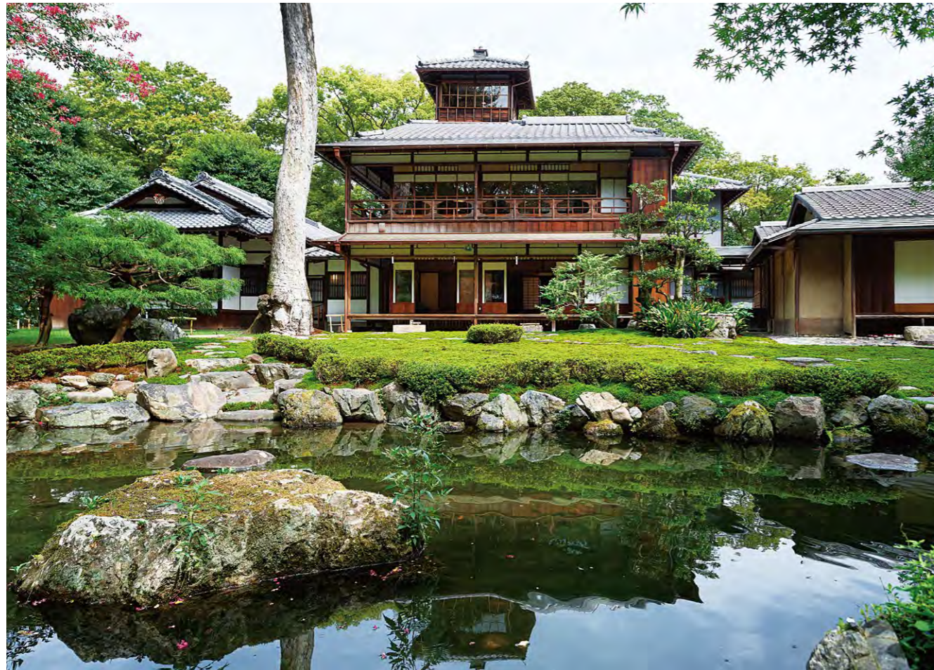
大正14年に竣工した下鴨別邸。明治期建造の木屋町別邸を移築して主屋とし、左に玄関棟を新築、右に江戸期の物と伝わる茶室を配している。
