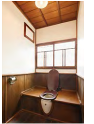
主屋2階便所。便器は和洋どちらにも使えた。
