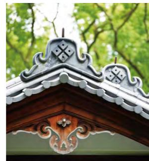
玄関棟の屋根瓦に見られる家紋「四つ目結」。古くは武家であった歴史を伝える。
