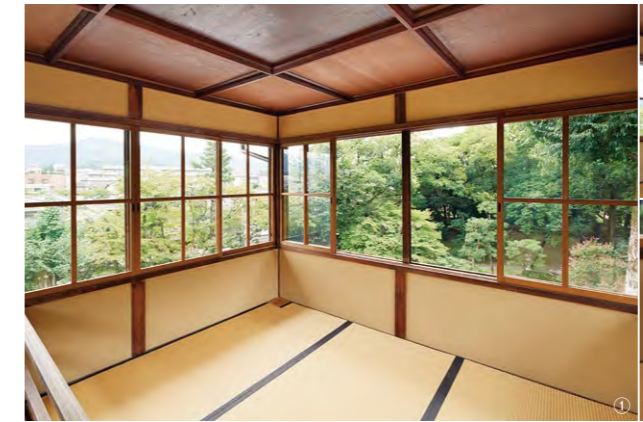
①3階の望楼は一間半四方で、全方向がガラス窓。東山・鴨川へ開ける眺望が素晴らしい。②視界を広げるために窓の位置には一切、壁を造っていない。雨戸は腰壁にある戸袋から引き上げる。③戸袋には横長の雨戸が収納されている。
