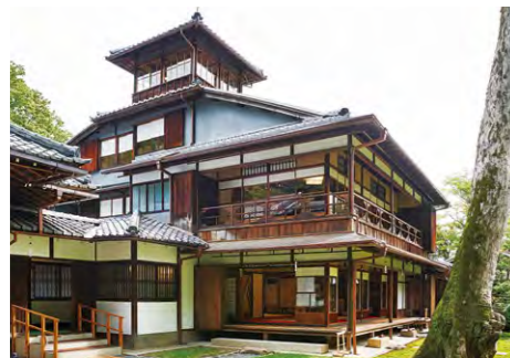
望楼・中3階が目目を引く主屋。目立たない所に壁を作ったり床にブレースを入れたり、建物の強度を高める工夫が見られるという。
