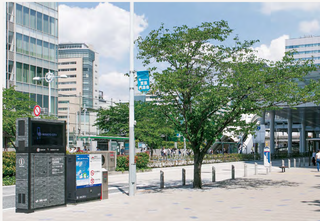
無電柱化に伴い地上に設置する配電地上機器を利用したストリートサイネージ。街並みに溶け込むラッピングが施されている (JR田町駅前)
