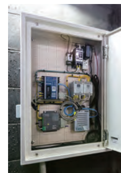
改修した電気室にエマネージと多回路エネルギーモニタを設置
