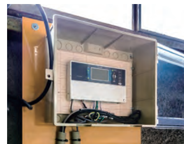
改修した電気室にエマネージと多回路エネルギーモニタを設置
