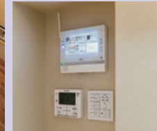
エネルギーモニタとパワーステーションのリモコン設定器。
