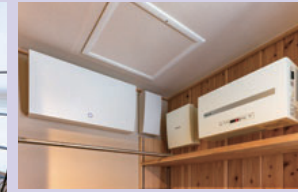
スマートコスモ、太陽光発電用パワーコンディショナ、接続箱。
