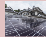
太陽光発電システム 20kW
