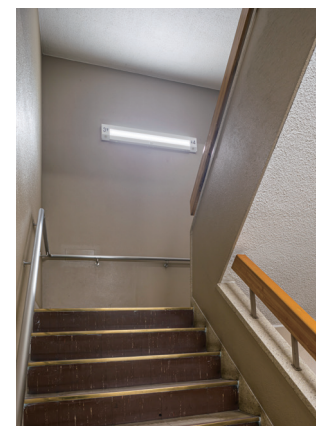
階段にはセンサ付きのLED階段灯を採用。人を検知して点灯するため、いない時は減灯し、省エネが可能です。
