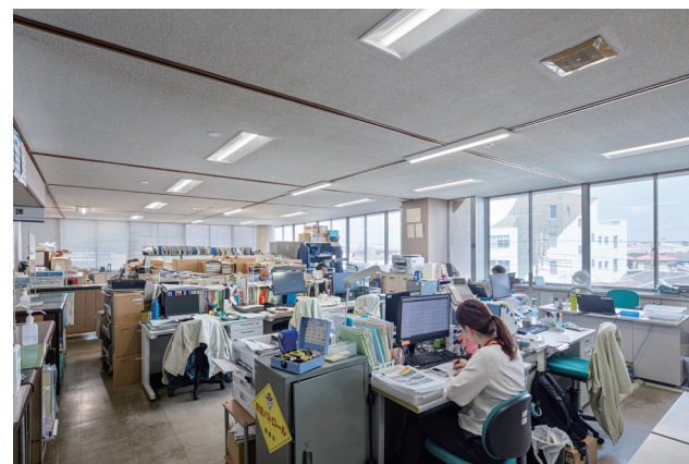
執務室はPiPit調光シリーズのLEDベースライトをご採用。昼光センサを組み合わせ、自動で一定の明るさに調光。タイム設定で17時半以降は照度を60%に落としています。さらにハンディライコンを使って調光したい器具に向けて個別に操作することも可能なため、不在席の頭上のみ消灯するなど、細かな省エネが可能です。
