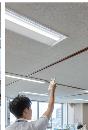
執務室はPiPit調光シリーズのLEDベースライトをご採用。昼光センサを組み合わせ、自動で一定の明るさに調光。タイム設定で17時半以降は照度を60%に落としています。さらにハンディライコンを使って調光したい器具に向けて個別に操作することも可能なため、不在席の頭上のみ消灯するなど、細かな省エネが可能です。
