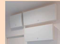
左上:集電盤 右上:スマートコスモ 下:電力切替ユニット
