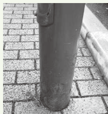
ポールの腐食した例
