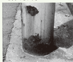
地際部 犬の尿により錆びた状態 一般社団法人 日本照明工業会「鋼製照明用ポール 点検・診断のすすめ」(JLA1018)より
