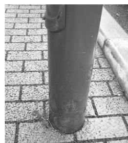
ポールの腐食した例
