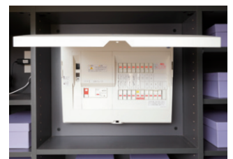
スマートコスモ HEMS対応の住宅分電盤。通信・計測機能を内蔵しています。
