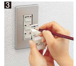
3 ●スイッチのハンドルをはずし鉛筆でアドレス(ナンバー)を記入する。 ●WRT9500Kの電源を切る。
