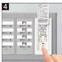
4 初期設定時は必ず「オールエリア外、除外設定用」スイッチを押す。(表示ランプ(赤)点灯) ●選択したパターンの内容を消去できます。(確認一部変更の場合4は行わない)
