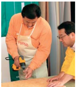
下穴をあけた位置にインパクトドライバーで木ネジを締めていく角田さん。
