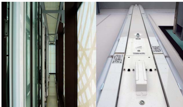
左：ダクト内に設置された照明器具。架台の影が室内に影響を及ぼさないように、架台をガラス面から8cm程度離している。 右：独自設計の取付架台と照明器具。垂直方向に2mピッチで配置。
