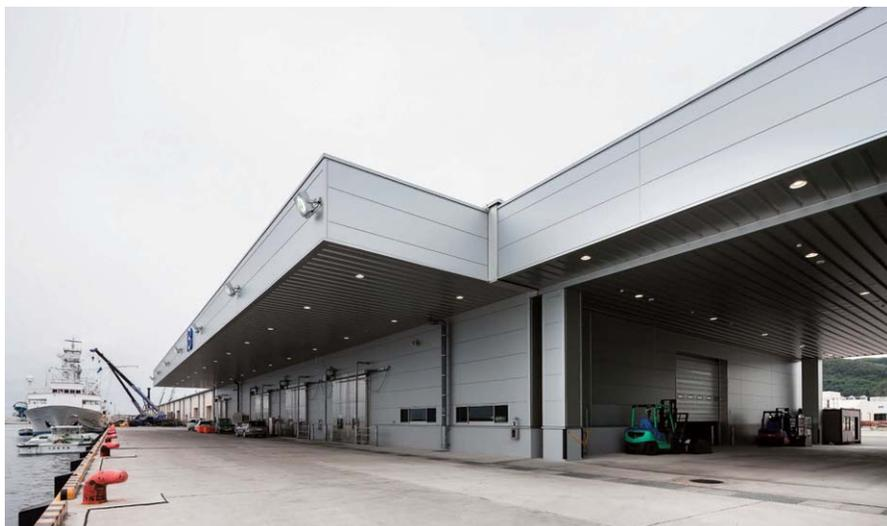
左：海側、荷上げ底部。右：荷さばき所。照明はRa85、5000Kの防湿型で重耐塩仕様、調光可能型の特注器具。
