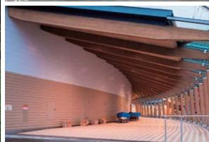
津波被害を受けた後(上)と、リニューアル後のドック棟(下)。津波により通路のガラス壁と展示物が被害を受けたため、ガラスを撤去し軒下空間に変更。照明器具もそれに合わせて変更すると共にLEDにリニューアル。
