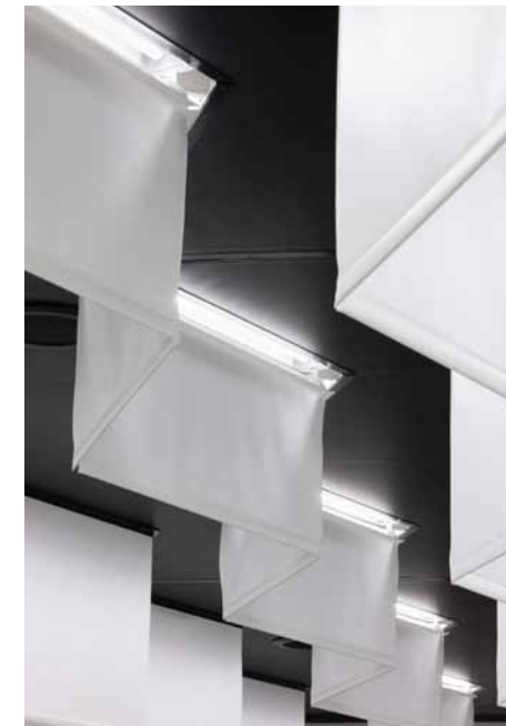
到着ロビー天井を見る。膜をどのように効果的に照らし照度と明るさ感を両立させるかシミュレーションを行った。
