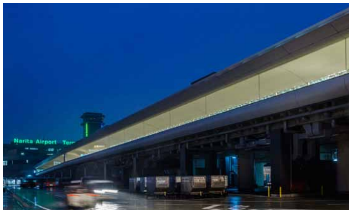
東側から見る外観。シャトル軌道の上に第2ターミナル本館とサテライトを繋ぐ連絡通路が設けられた。
