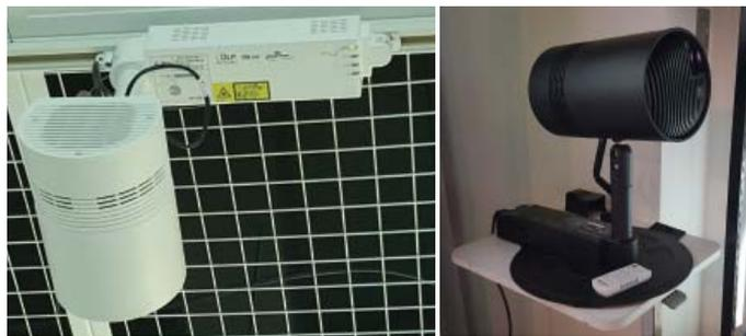
写真3 配線ダクトに設置
