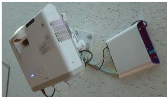
写真5 天井吊り用の金具を使用して設置
