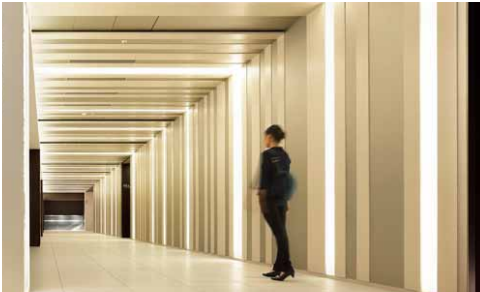
商業施設が面している2階廊下。壁と天井のアクリルパネルの内側に蛍光灯を仕込んでいる。壁と天井は2種類の仕上げ材と照明のラインをランダムに並べることで華やかな雰囲気をつくっている。*2 *2撮影：Nacasa & Partners／中道淳
