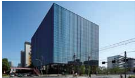
北側外観。外形は約60mの立方体。北東、北西面の外壁はカーテンウォールで垂直フィンにより日射を制御している。*1
