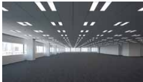
基準階オフィス。グリッドシステム天井照明。昼光センサーで照明を制御している。*1 *1撮影：エスエス／島尾望
