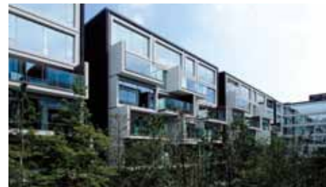
中庭越しに住戸を見る。各住戸のリロニーは、上下に隣接する住戸のリロニーとずらして配置することで、容積に算入されないようにしながら広い面積を確保している。
