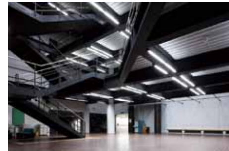
「中央大学 多摩キャンパス 6・7号館ホール」。白く塗装した天井と、上にも光が漏れる照明器具により、梁型によってできる影がほとんどなくなっている。Feu実測値：7.2、平均床面照度：約350lx。
