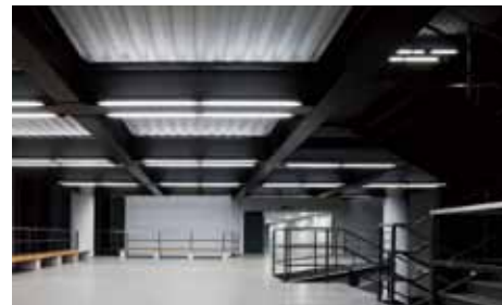
「中央大学 多摩キャンパス 6・7号館ホール」吹き抜けの2階。H鋼の梁型に沿って照明器具が直付けされている。
