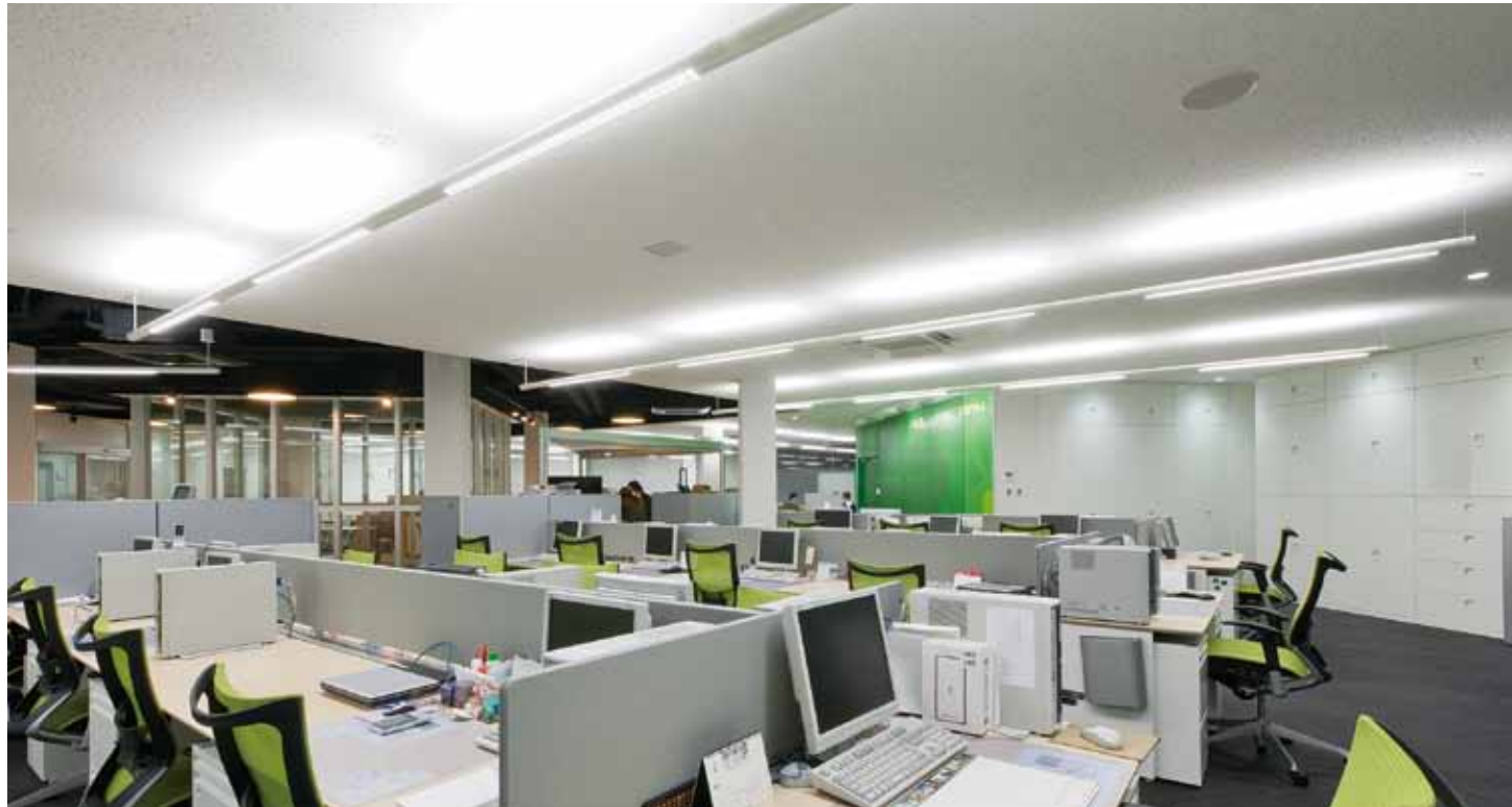
「協和医科器械本社」3階オフィス。机のレイアウトに合わせて照明器具を配置。上下配光の照明器具を使うことで、机上面照度だけでなく空間の明るさ感をアップさせている。正方形の平面に対して机の向きを45度振ったレイアウトで、コミュニケーションの活性化を図っている。左奥の「光シャフト」は自然通風と採光に利用している。写真提供：パナソニック電工
