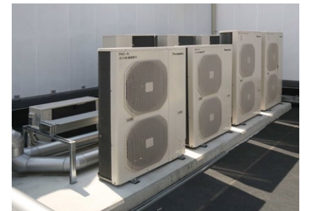
エアコン室外機には、メンテナンスしやすいようにエリアを明記
