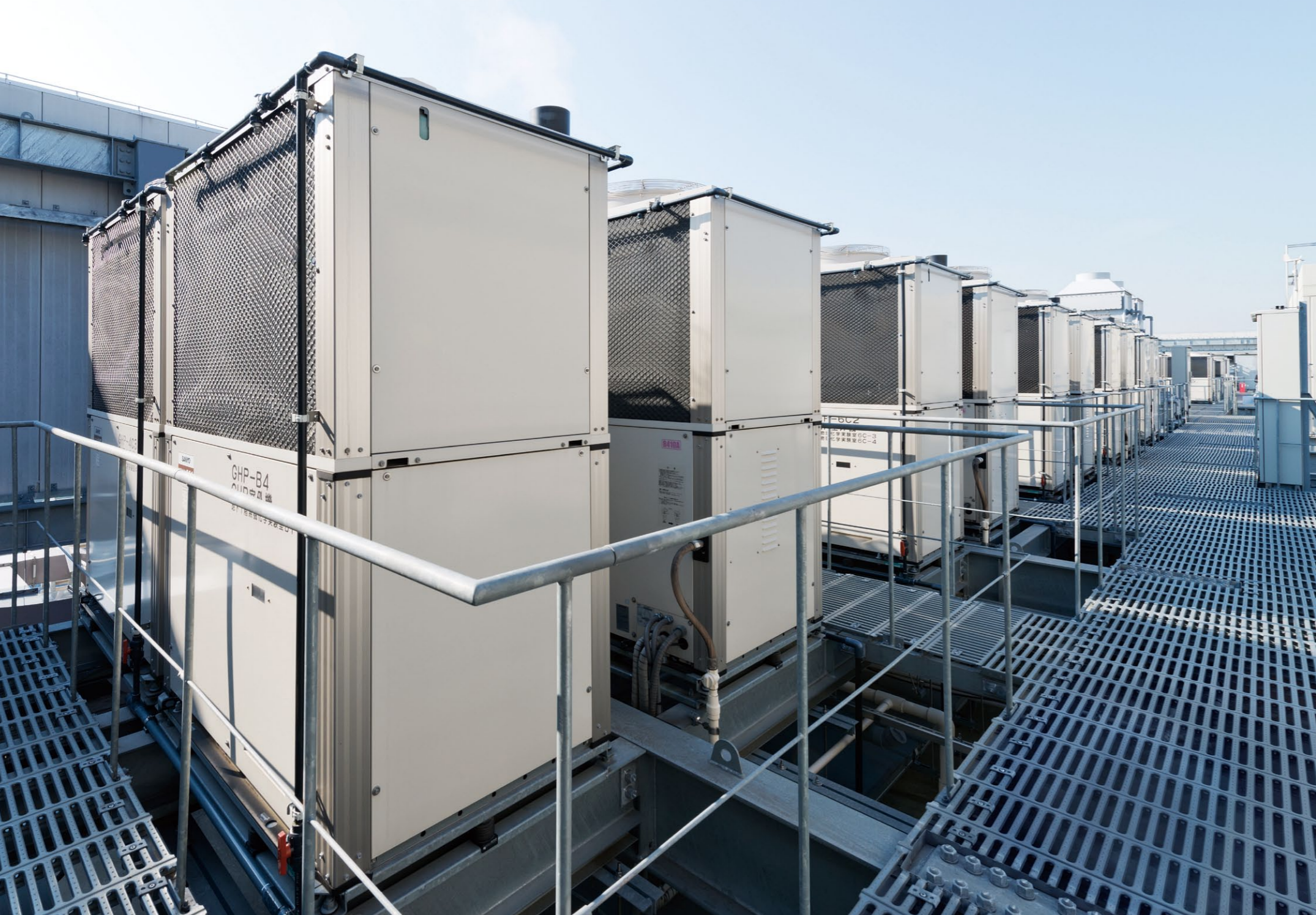
中央教育研究棟の屋上に設置されたGHP室外機
