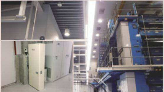
施主様の総工費抑制のご要望から、「エネ合」の補助金活用を提案されました。空調・照明の稼働時間を部屋ごとに徹底調査し、LED照明、空調、ボイラーを更新。さらに、蓄電池とエマネージを導入することで申請要件である10%以上の省エネ、5%以上のピーク対策をクリアし、その明確な効果が評価されて、補助金交付が決定しました。
