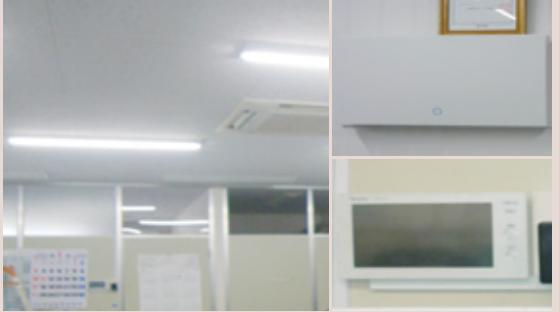
施主様の自社ビル ZEB化リニューアル。小規模物件のBEMS導入はコストがかさむため、経済産業省の補助金活用に際して、環境共創ニシアチブにHEMSによる対応の認可を交渉。建築と照明、高効率空調設備の導入で削減率82%を達成し採択されました。今回のノウハウを活かしてZEB化事業の水平展開を計画されています。
