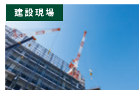
建設現場 仮設設営でのインフラ構築に
