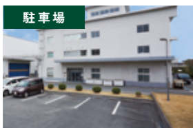
駐車場 監視カメラの設置に
