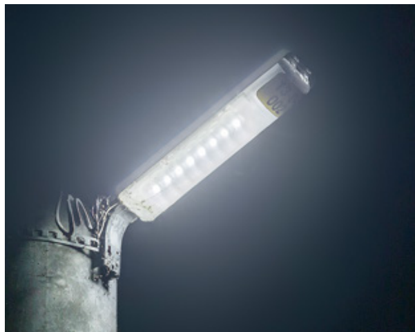
東北電力が公衆街路灯の10W以下の料金を新たに設定したことに伴い、10W以下のLED防犯灯を採用。あらかじめ試験設置をして十分な明るさであることも確認しています。
