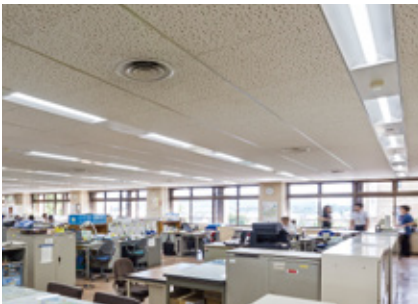
本庁舎執務室：窓側2列は無線調光タイプのLED照明（PiPit調光）を導入。日中は照度を落としてさらなる省エネを実現。
