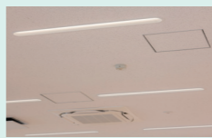
熱交換気ユニット 天吊カセット形
