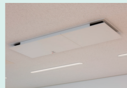
熱交換気ユニット 天吊カセット形
