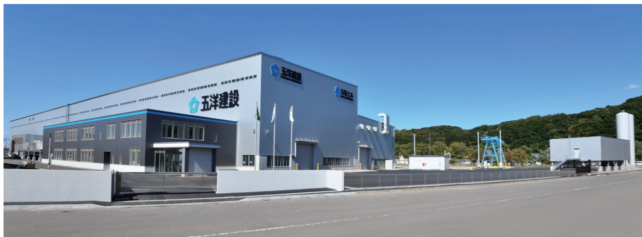
五洋建設株式会社 室蘭製作所(工場棟+事務所棟)
