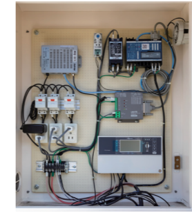
エマネージコントローラ・ エマネージパルス検出ユニット
