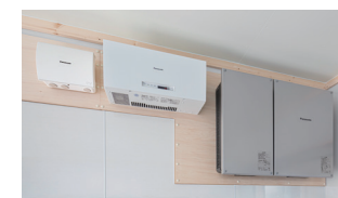
左から:接続箱、パワーコンディショナ、 蓄電池用コンバータ、パワーステーション
