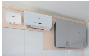
左から:接続箱、パワーコンディショナ、蓄電池用コンバータ、パワーステーション
