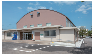
令和6年 町立体育館(他2施設)
