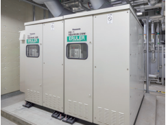
吸収冷温水機
