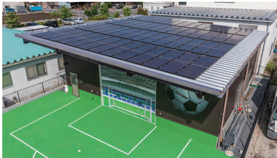
▲新しい倉庫の屋上には、住宅用太陽光発電システムHIT (25kWh)を設置
