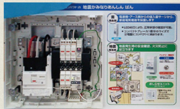
夏祭りに出展した「感震ブレーカー・分電盤」のデモ機。地震発生後にブレーカがOFFになることを体感いただき、通電火災への備えについて説明できます。
