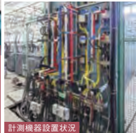
計測機器設置状況
