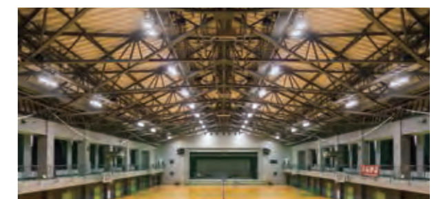
試験点灯による検証や、拡散パネルの設置によるまぶしさの軽減など、利用する児童・学生に配慮しながらLED化。
