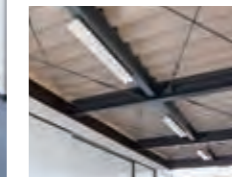
直管LEDランプ搭載ベースライト 防湿・防雨型(軒下)
