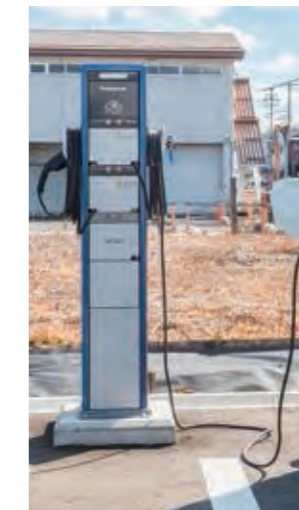
EV・PHEV充電用充電スタンドエルシーヴ(左)。室内で操作できる電源スイッチもアドバンスシリーズをご採用(上)。スイッチを「切」にすれば盗電を防止できます。
