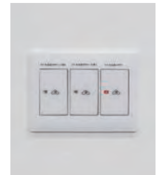
EV・PHEV充電用充電スタンドエルシーヴ(左)。室内で操作できる電源スイッチもアドバンスシリーズをご採用(上)。スイッチを「切」にすれば盗電を防止できます。
