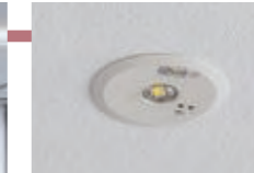
LED非常用照明器具
