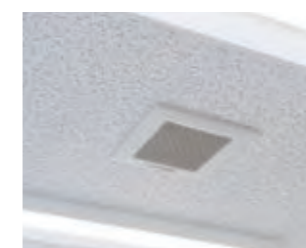
会議室の換気扇には省エネ・低騒音タイプのDCモータータイプをご採用。24時間換気でもわずかな消費電力で、「音もわからないぐらい静か」と好評です。
